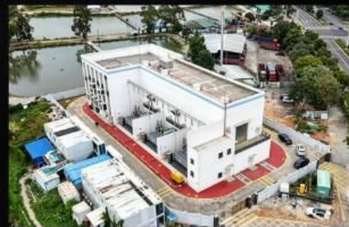
南方电网东莞变电站
