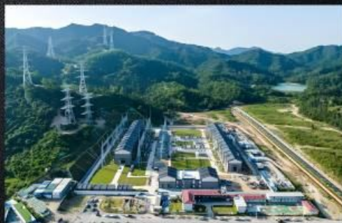
南方电网珠海变电站
